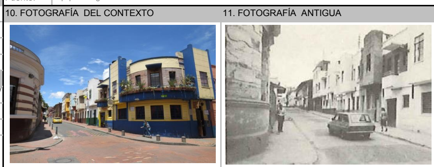
Fuente: Equipo Fotografía PEMP Patrimonio Inmueble
