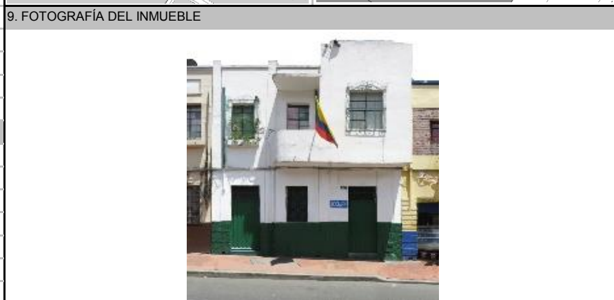
Fuente: Equipo Fotografía PEMP Patrimonio Inmueble
